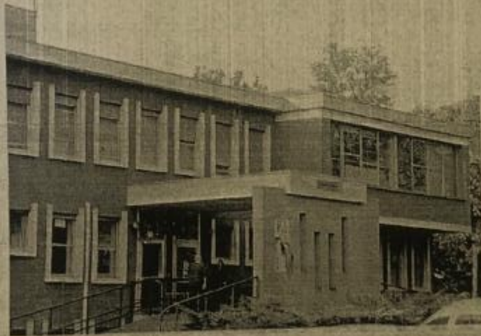
La palazzina del poliambulatori situata all'ingresso del presidio sanitario Corberi di Mombello
